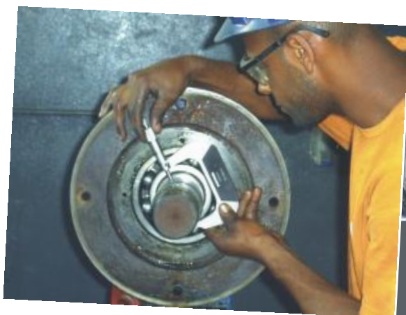
Serviço de Recuperação de Bombas e Reposição de Peças
