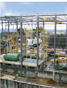
Planta concentradora de mineral de wolframio en fase de construcción.
