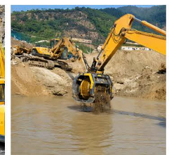
TRABAJOS EN CAUCES Y RIBERAS
